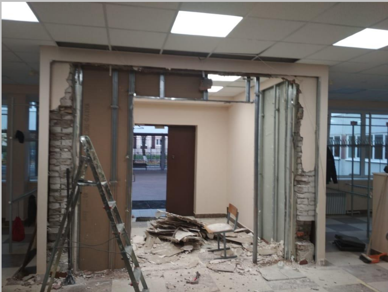
Демонтаж конструкций для расширения пространства под установку системы
